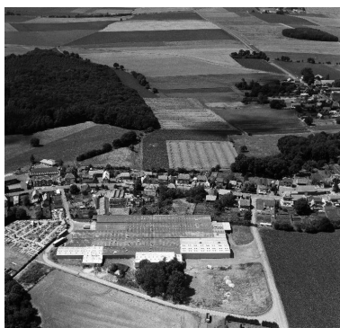
Vue aérienne, flanc est.
