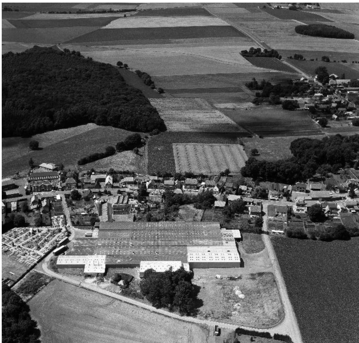
Vue aérienne, flanc est.
