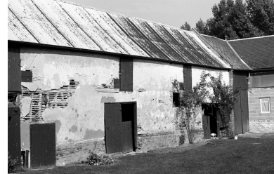
Vue des étables en torchis fermant le côté nord-ouest de la cour.
