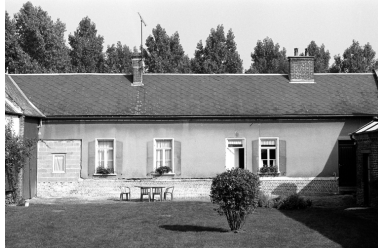
Vue du logis : la façade antérieure, ouvrant sur la cour de ferme.
