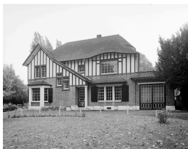
Élévation antérieure. Phot. Thierry Petitberghien IVR31_20015902285V
