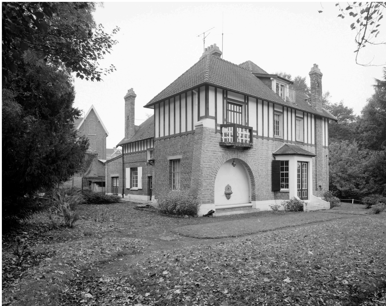
Élévation de trois quarts (élévations latérale et postérieure).
