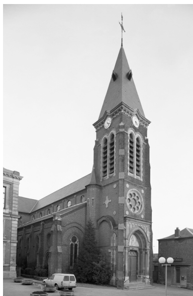
Vue générale. Phot. Thierry Lefébure IVR22_19960201033P
