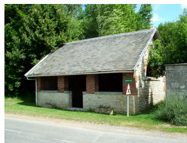
Vue du lavoir.
