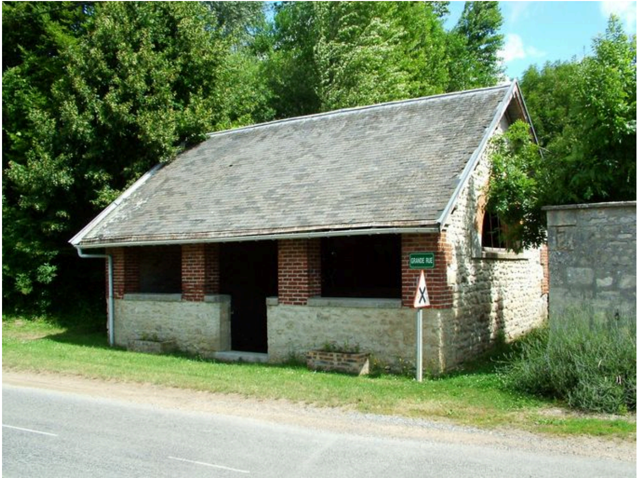
Vue du lavoir.
