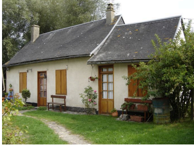
Vue du logis. Phot. Inès Guérin IVR22_20078005210NUCA
