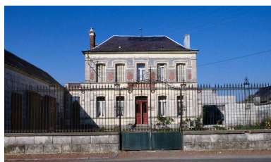
Vue générale d'une maison. Phot. Martine Plouvier IVR22_19900202823ZA
