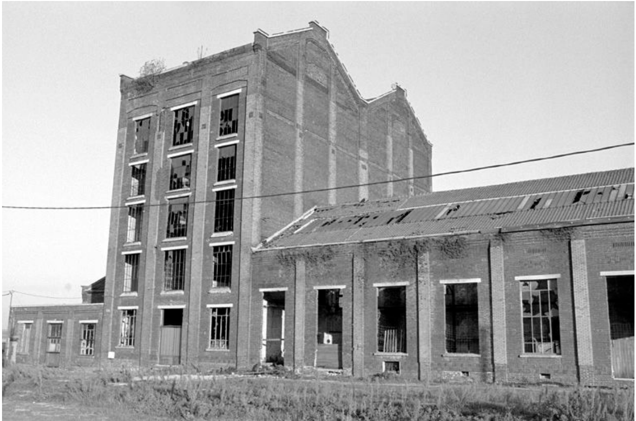
Atelier de fabrication, vue générale
