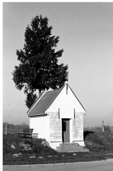
Oratoire, dit chapelle Sainte-Anne. Phot. Judith Förstel IVR22_20018000007Z
