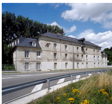
Façade postérieure du moulin Mazeau. Phot. Thierry Lefébure IVR22_20106000528XA
