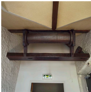
Le tire-sac situé dans la partie supérieure du moulin était actionné par l'arbre vertical. Phot. Thierry Lefébure IVR22_20106000473XA
