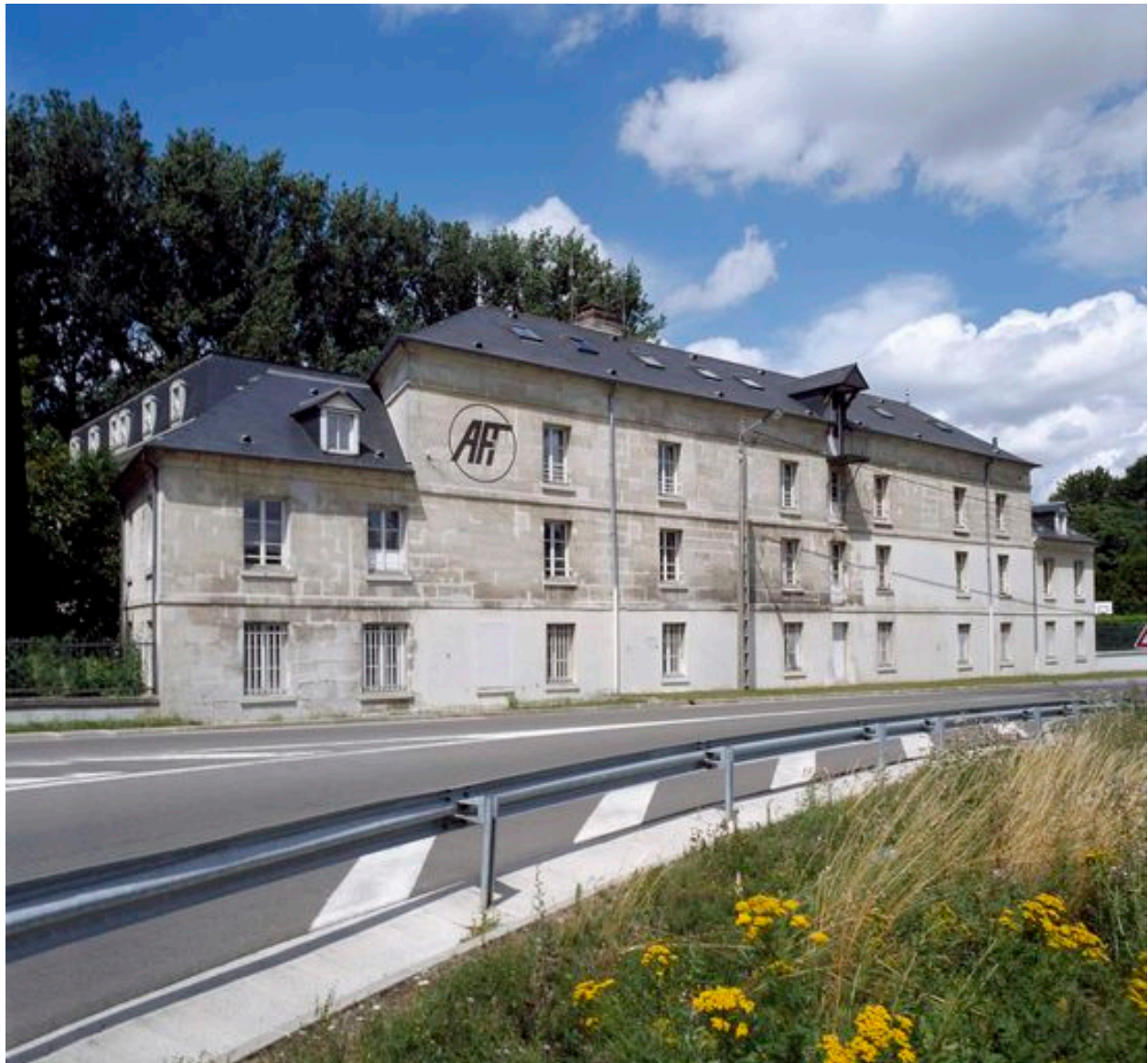
Façade postérieure du moulin Mazeau.
