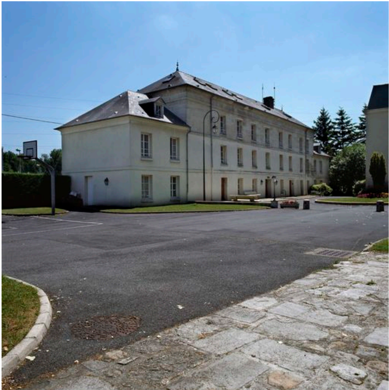
Vue générale du Moulin Mazeau depuis la cour.
