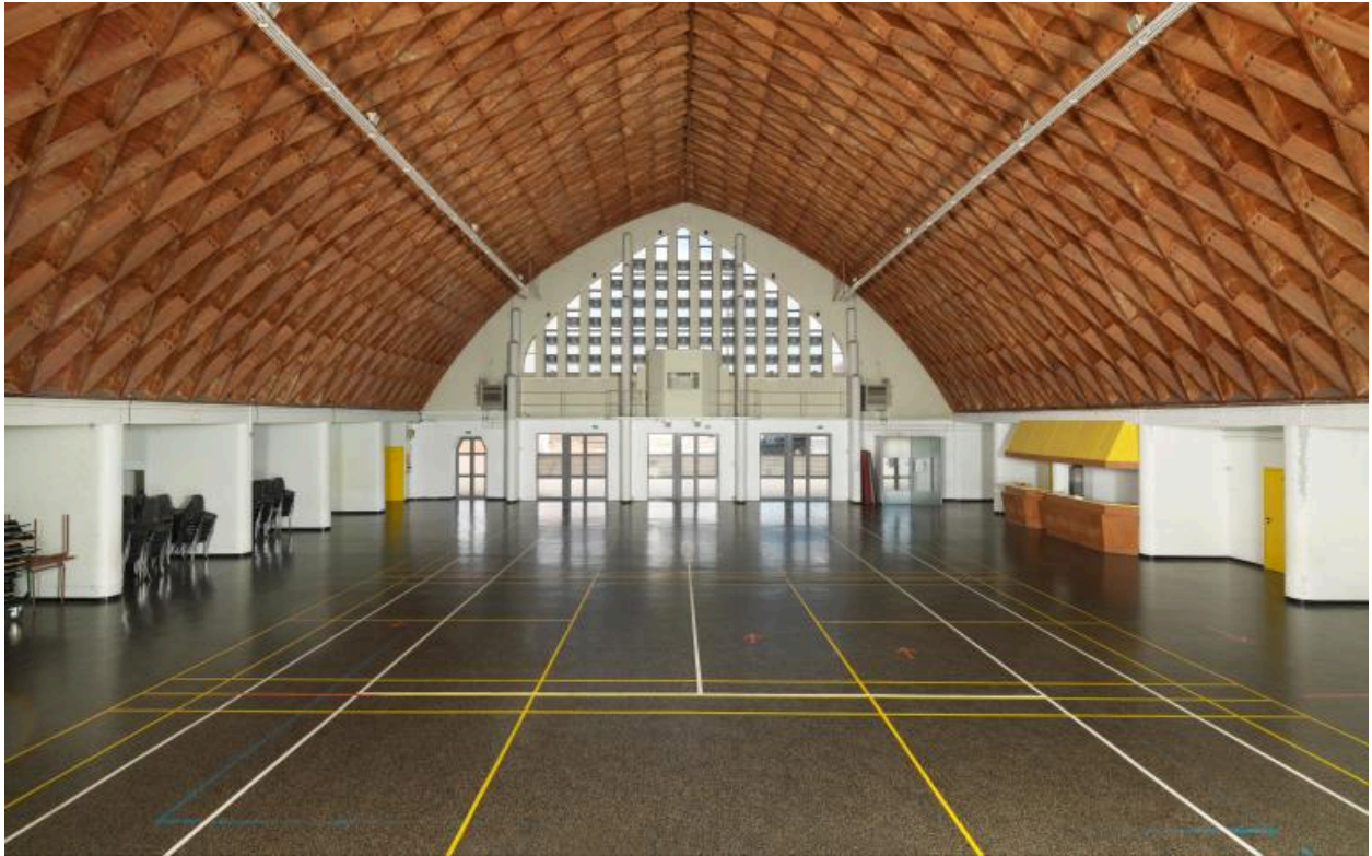
Vue intérieure vers le nord.
