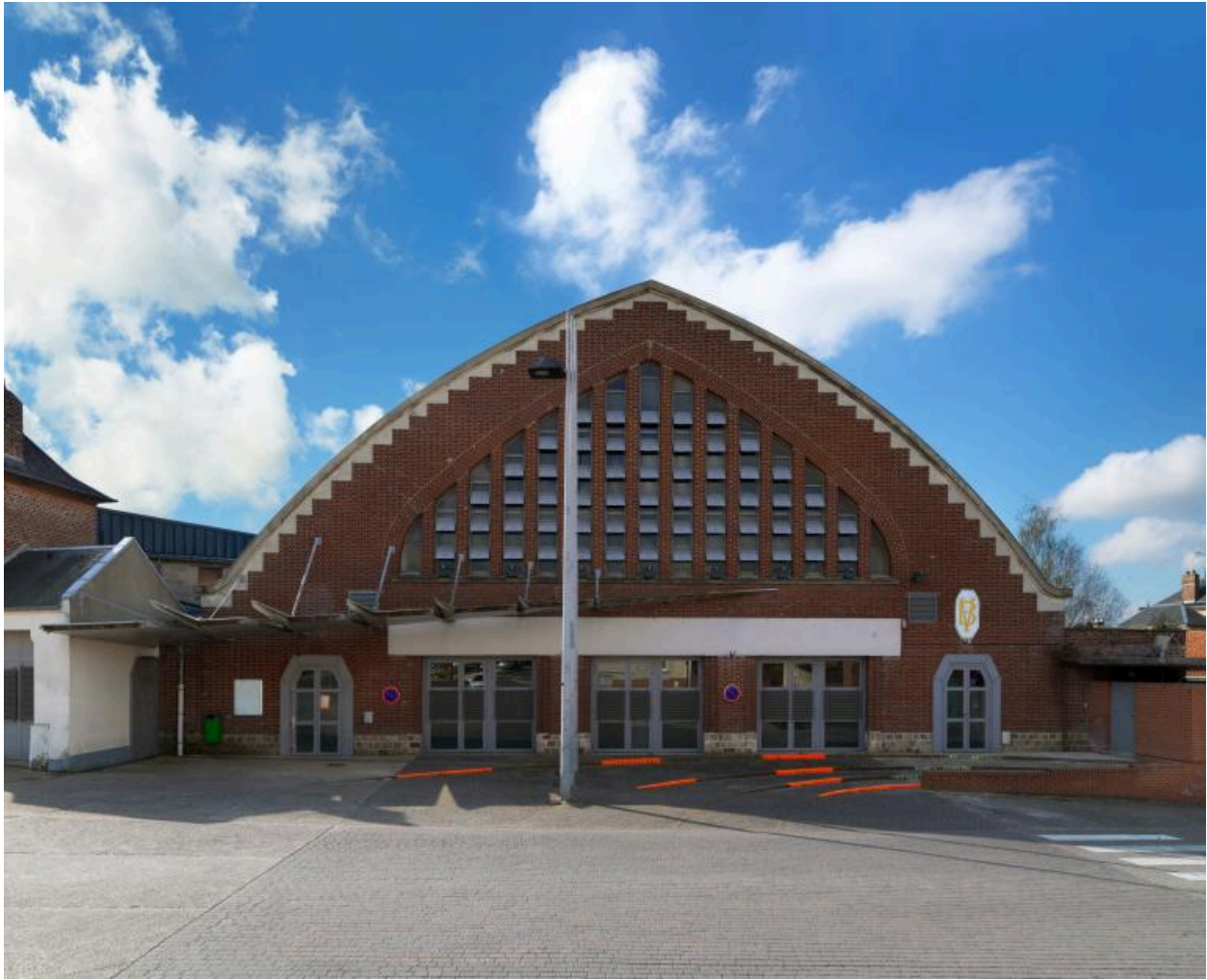
Vue de la façade nord.
