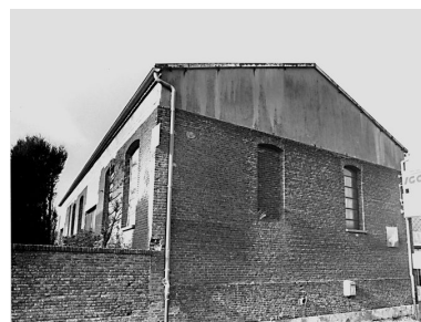
Usine de matériel agricole Fetro-Lefèvre, 15 Grand'rue : atelier de fabrication. Phot. Xavier-Philippe Guiochon IVR22_19980201464Z
