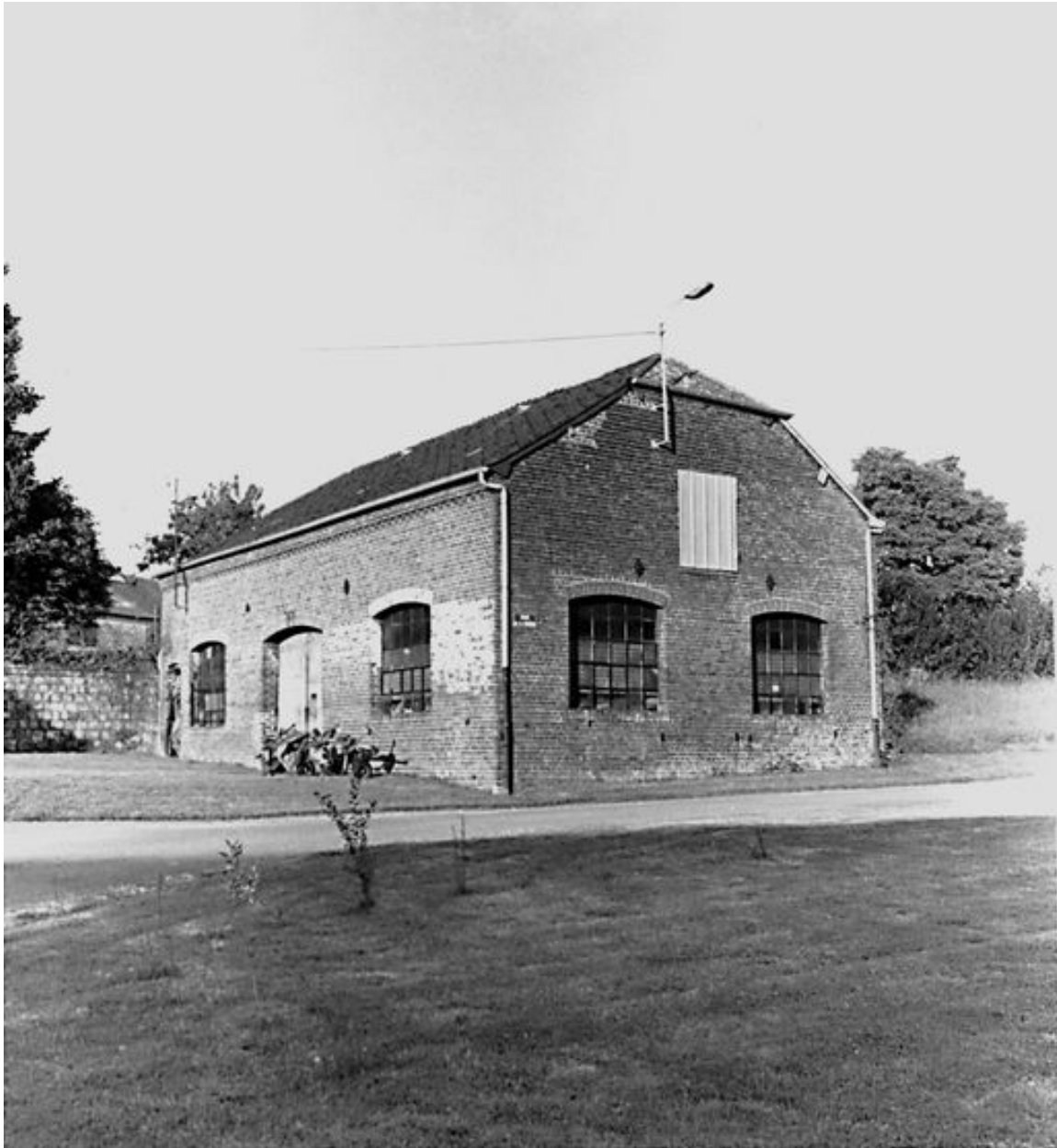
Forge, rue de la Rivière (1er quart 20e siècle).
