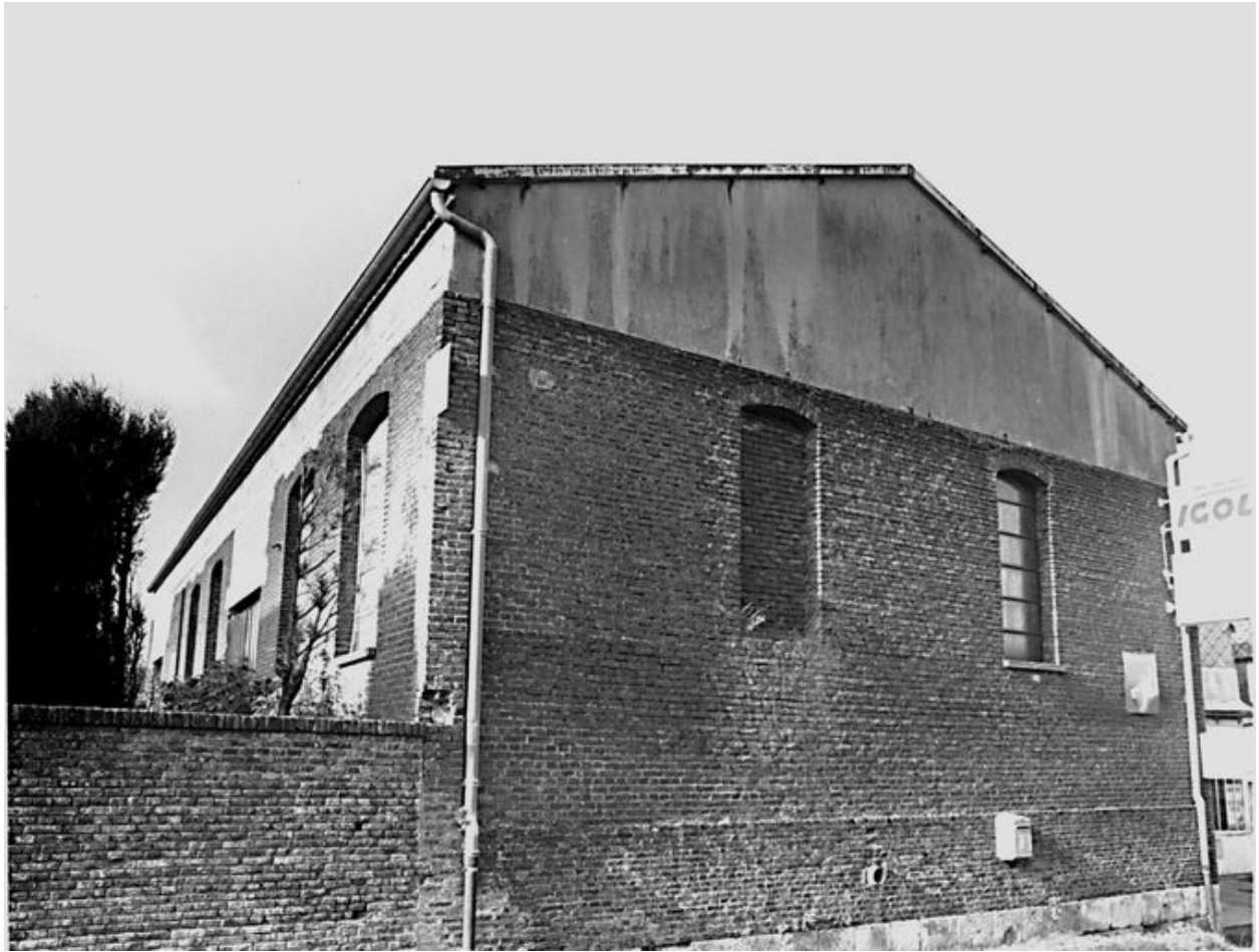
Usine de matériel agricole Fetro-Lefèvre, 15 Grand'rue : atelier de fabrication.
