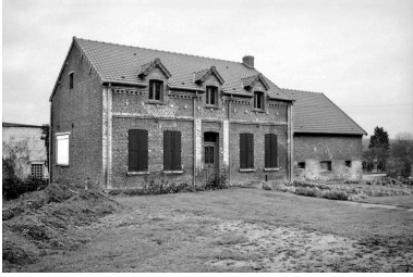
Vue de la façade principale. Phot. Frédéric Fournis IVR22_20030200170Z
