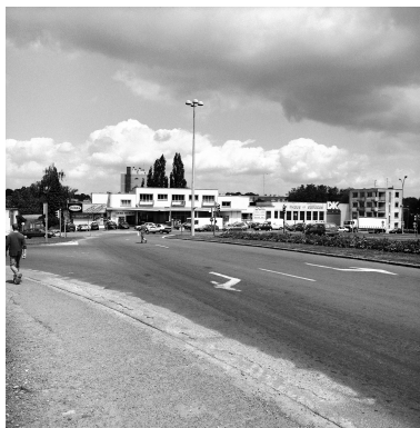
Vue générale du garage, de l'atelier et de l'immeuble à logements. Phot. Thierry Petitberghien IVR31_20025902032X
