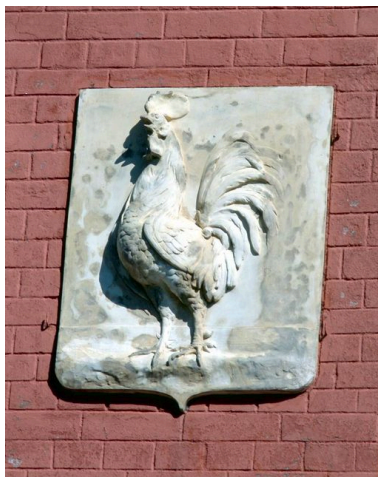
Détail du coq sculpté ornant la façade.
