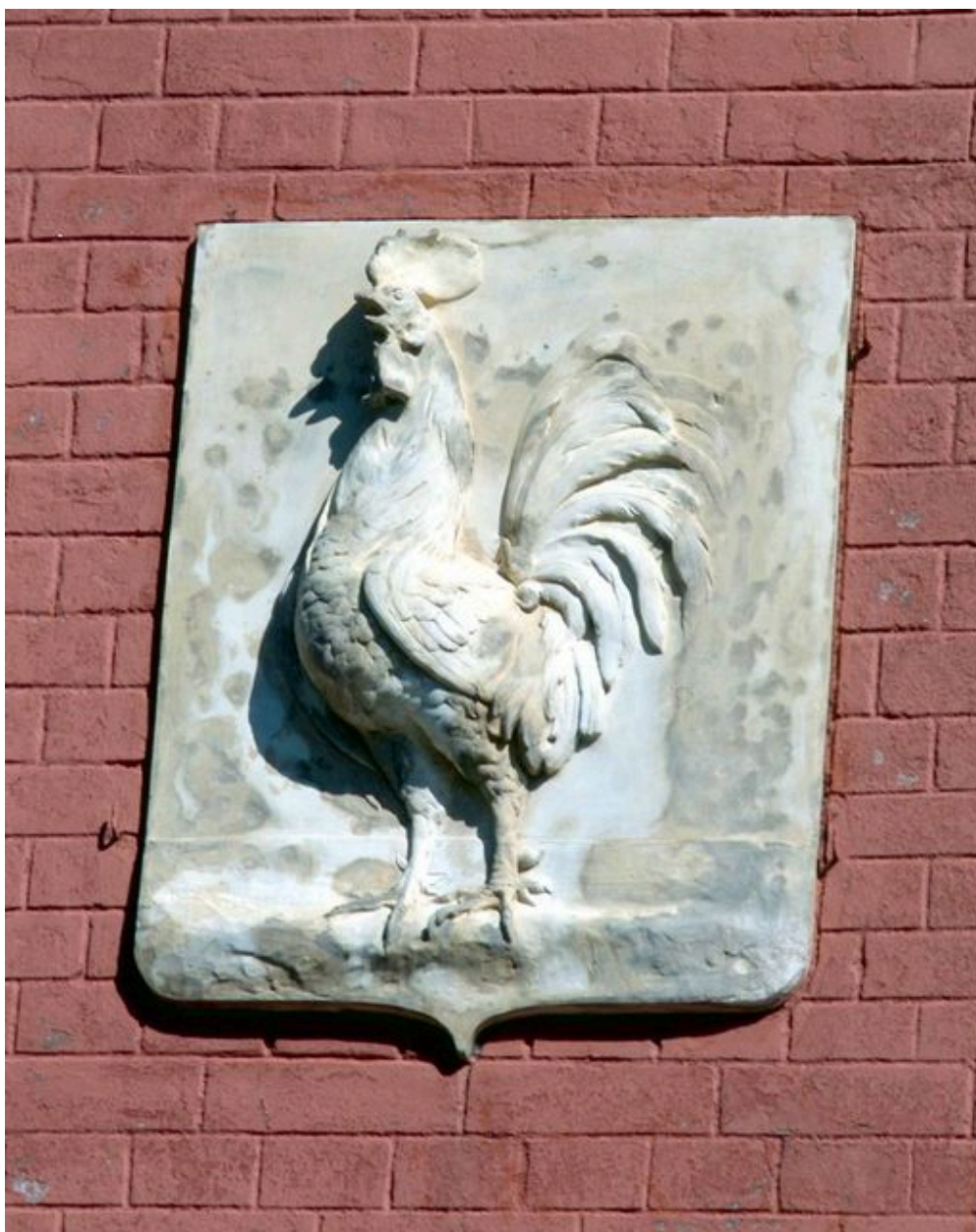
Détail du coq sculpté ornant la façade.
