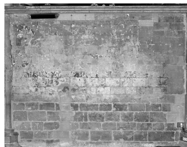
Décor de la travée droite du mur de clôture sud. Phot. Thierry Lefébure IVR22_20010202816V
