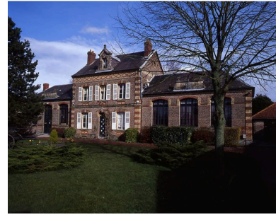
Vue de la mairie-école de Ponthoile. Phot. Irwin Leullier IVR22_20078000047XA
