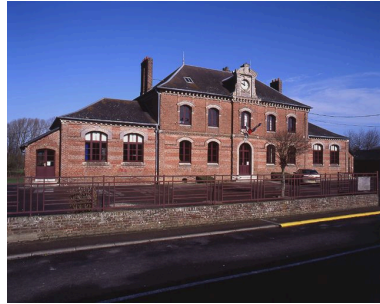
Vue de la mairie-école de Pendé. Phot. Irwin Leullier IVR22_20078000062XA
