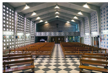
Vue générale depuis le chœur.
