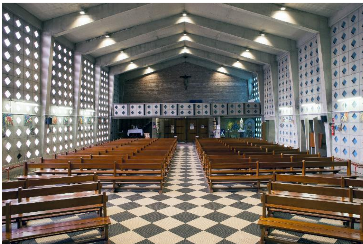
Vue générale depuis le chœur.
