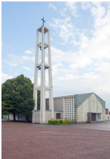
Campanile et vue de trois quart gauche de la façade antérieure de l'église.
