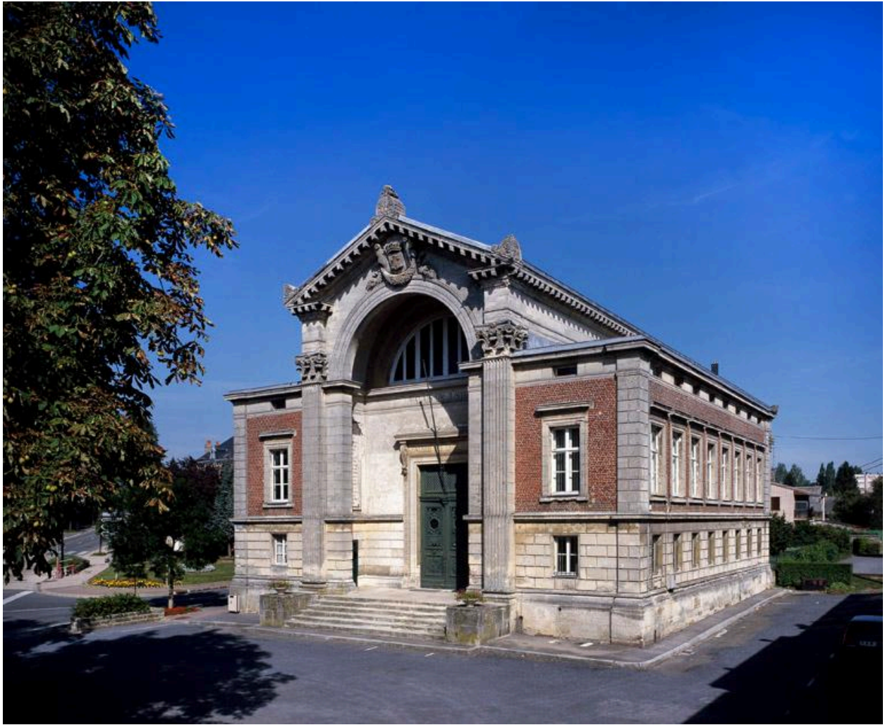
Vue des élévations sud et est du palais : état de la façade avant restauration en 1997.
