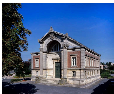
Vue des élévations sud et est du palais : état de la façade avant restauration en 1997. Phot. Laurent Jumel IVR22_19970200916VA
