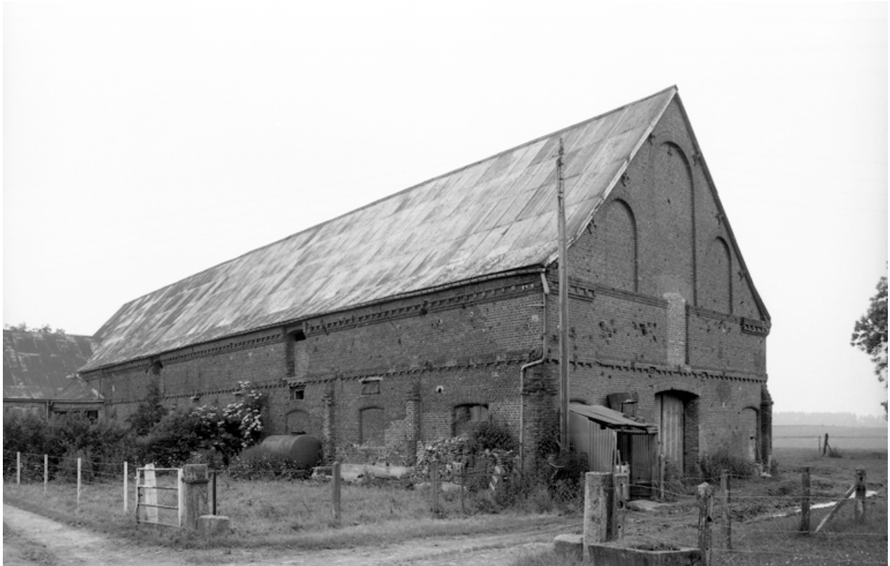
Vue de l'étable au nord-ouest.
