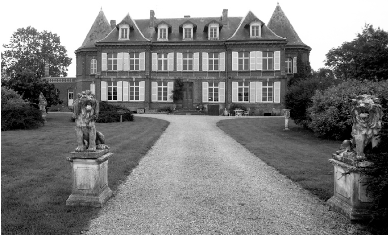
Vue d'ensemble de la façade du logis.
