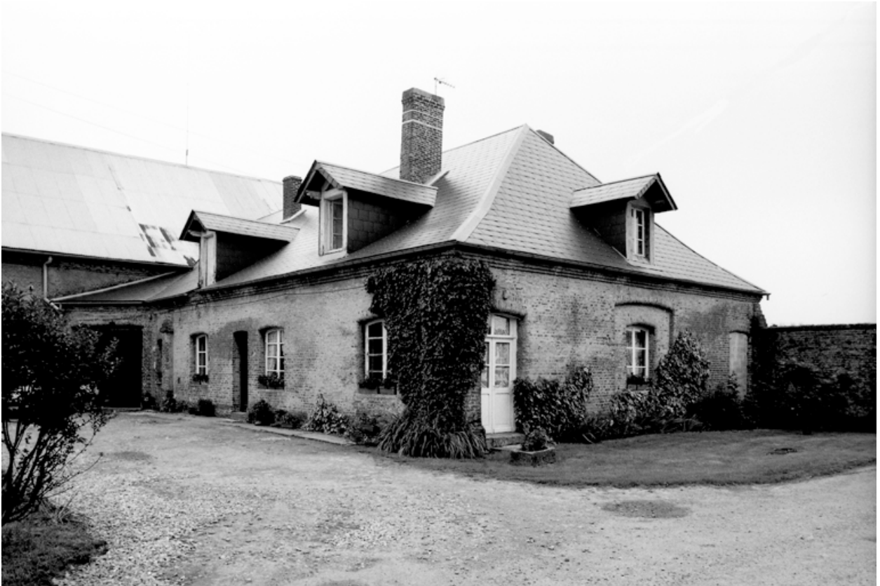
Détail du logement attenant à l'étable sud.
