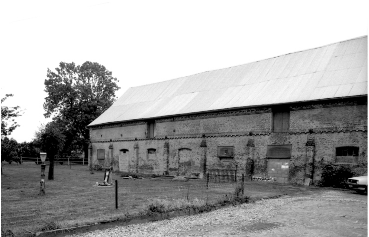
Vue partielle de l'étable sud.
