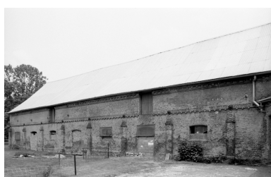
Elévation sur cour de l'étable sud. Phot. Thierry Lefébure IVR22_19920201060Z
