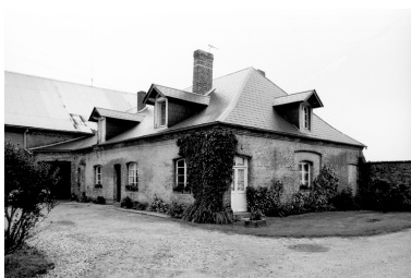
Détail du logement attenant à l'étable sud. Phot. Thierry Lefébure IVR22_19920201058Z
