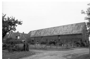
Vue d'ensemble de l'étable nord-ouest. Phot. Thierry Lefébure IVR22_19920201055Z
