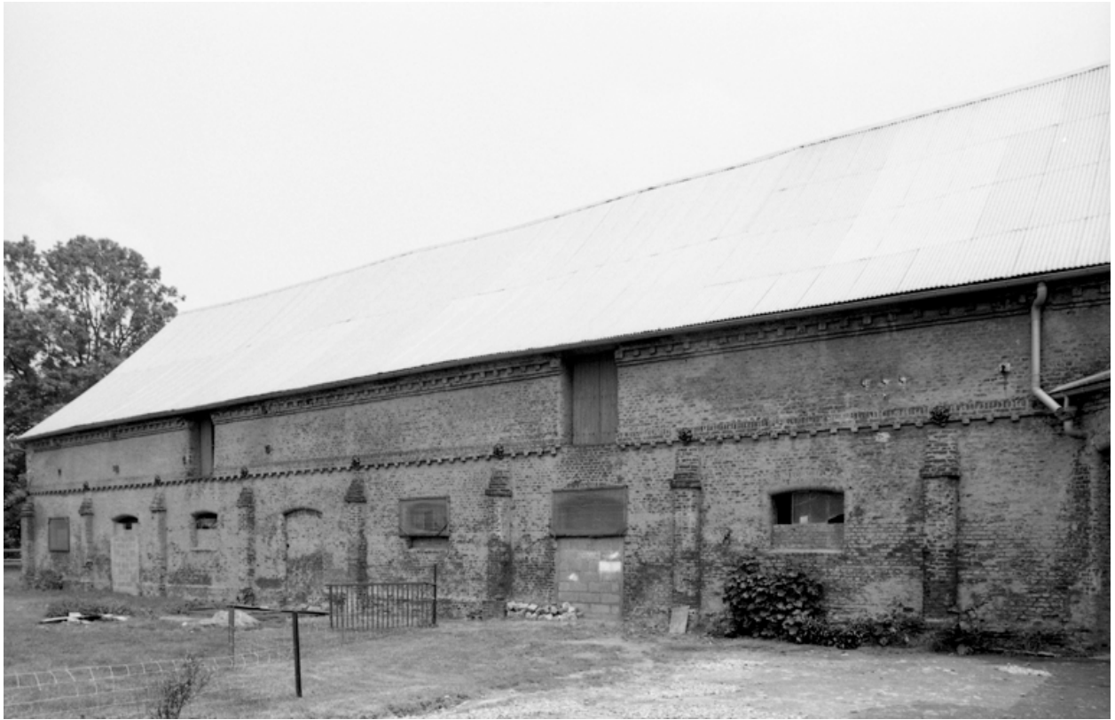
Elévation sur cour de l'étable sud.
