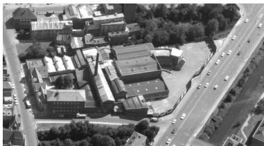
Vue aérienne, depuis le nord. Phot. Phot'R IVR22_19908000905P
