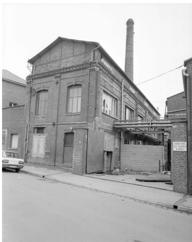
Atelier de fabrication, conciergerie, local technique et vestiaire. Élévation nord-ouest. Phot. Thierry Lefébure IVR22_19908001838X
