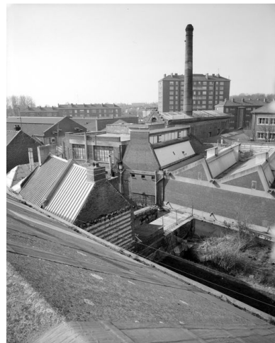
Vue partielle flanc sud-ouest. Phot. Thierry Lefébure IVR22_19888000511V
