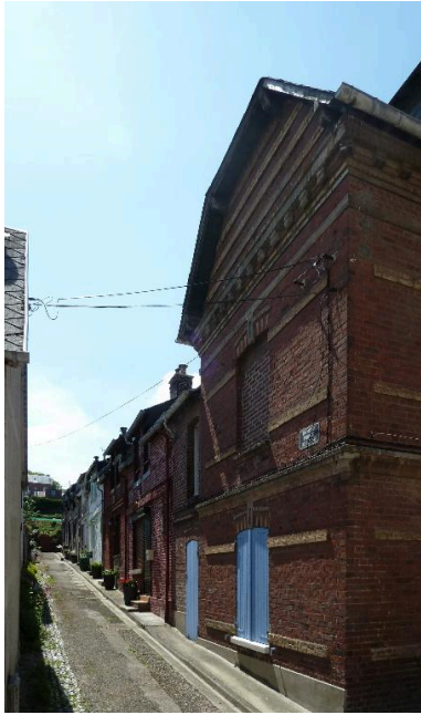
Vue de trois-quarts depuis l'entrée de l'impasse. Phot. Frédéric-Nicolas Kocourek IVR22_20158006090NUCA
