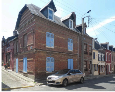
Logement de contremaître. Phot. Isabelle Barbedor IVR22_20158006714NUCA
