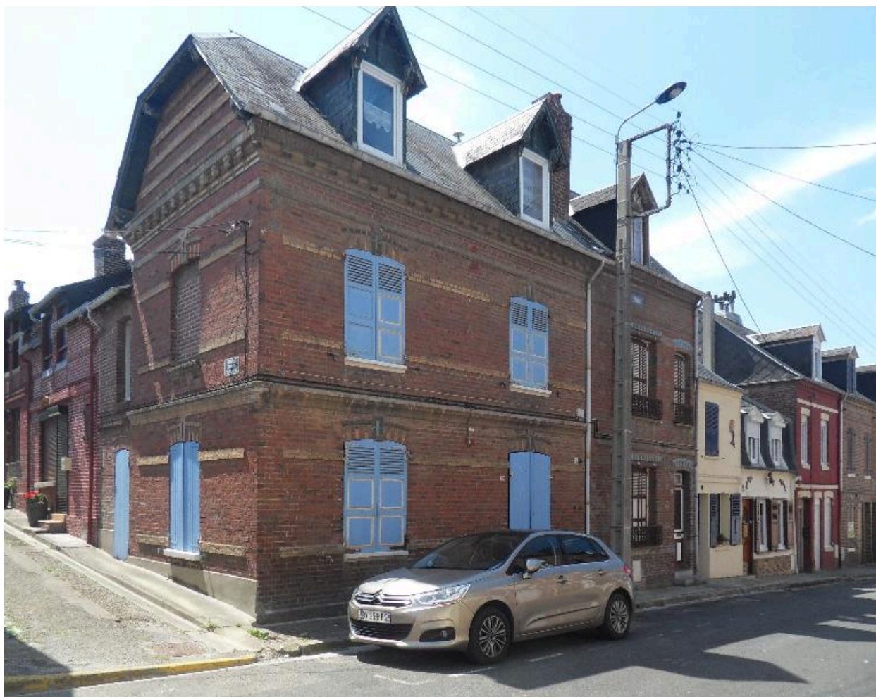
Logement de contremaître.
