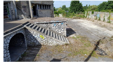
Détail de l'escalier descendant vers les bassins. Phot. Laurence Schlosser IVR32_20178005077NUCA
