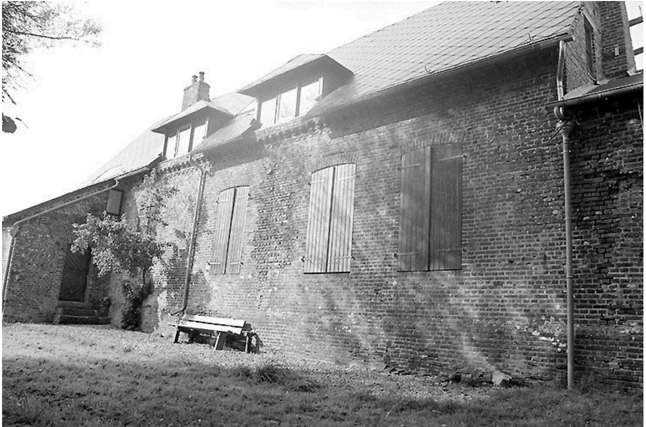
Façade postérieure du logis.
