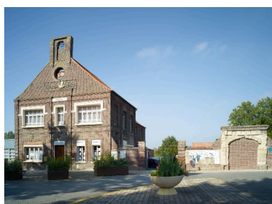
Vue générale de l'actuelle mairie, installée dans une ancienne ferme (?). Phot. Pierre Thibaut IVR31_20155901584NUCA
