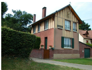
Conciergerie et logement du concierge. Phot. Bertrand Fournier IVR22_20036000559NUCA
