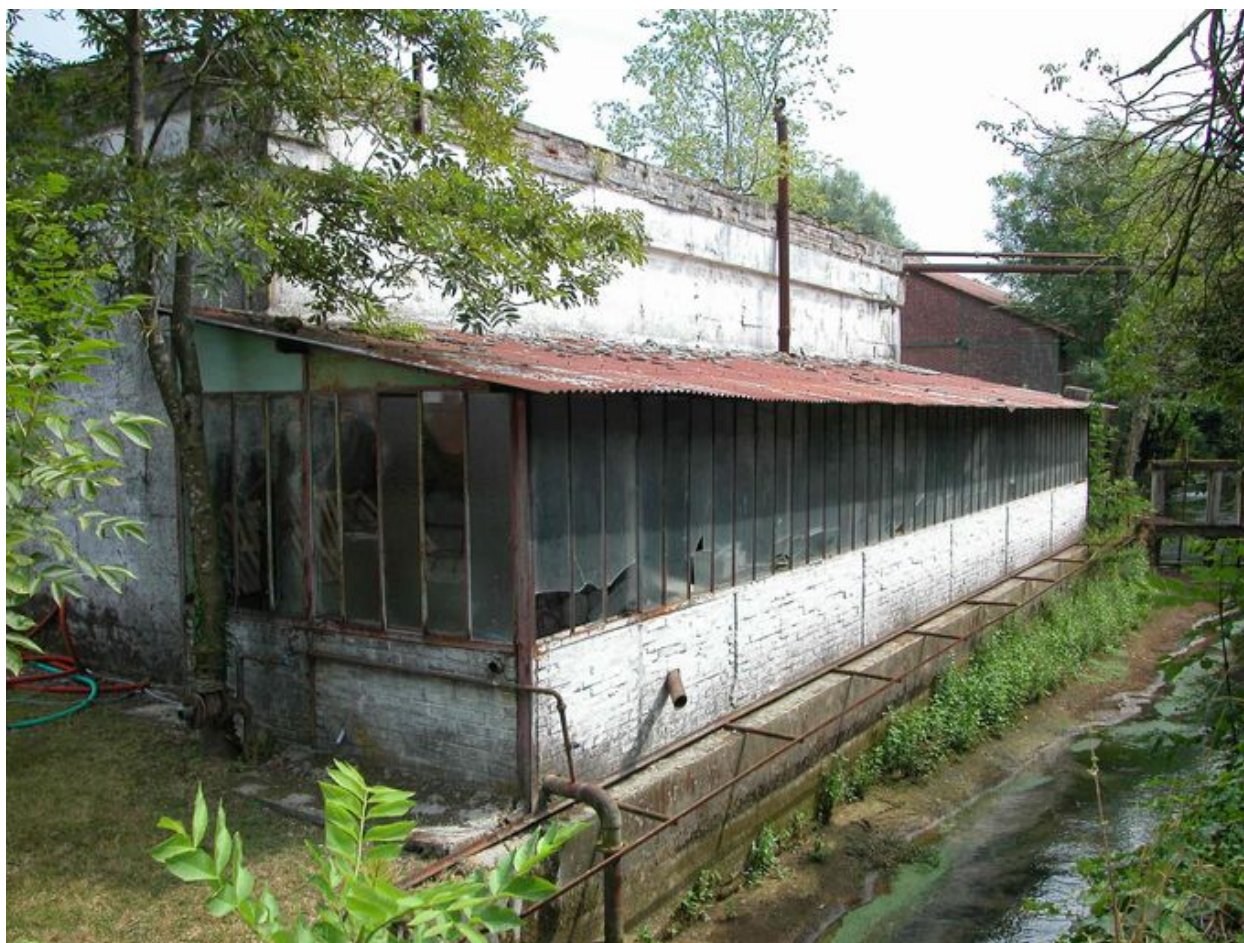
Atelier de rouissage des lins, façade nord.
