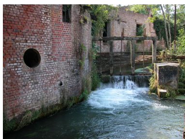
Détail du vannage de décharge. Phot. Bertrand Fournier IVR22_20036000579NUCA
