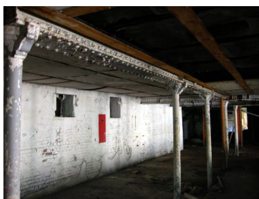
Intérieur du sous-sol de la fromagerie, vue d'ensemble des supports métalliques Phot. Bertrand Fournier IVR22_20036000573NUCA
