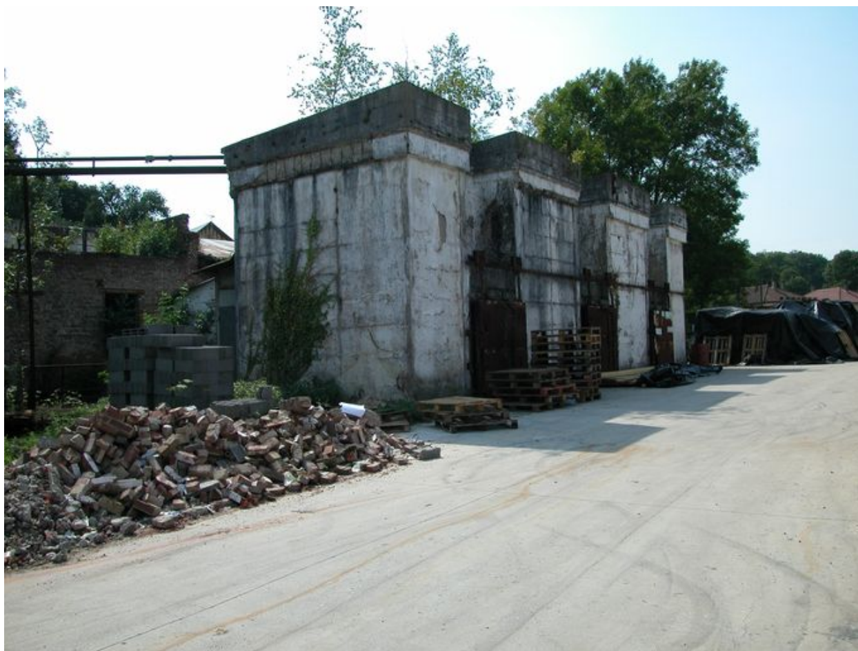
Atelier de rouissage des lins, façade sud.
