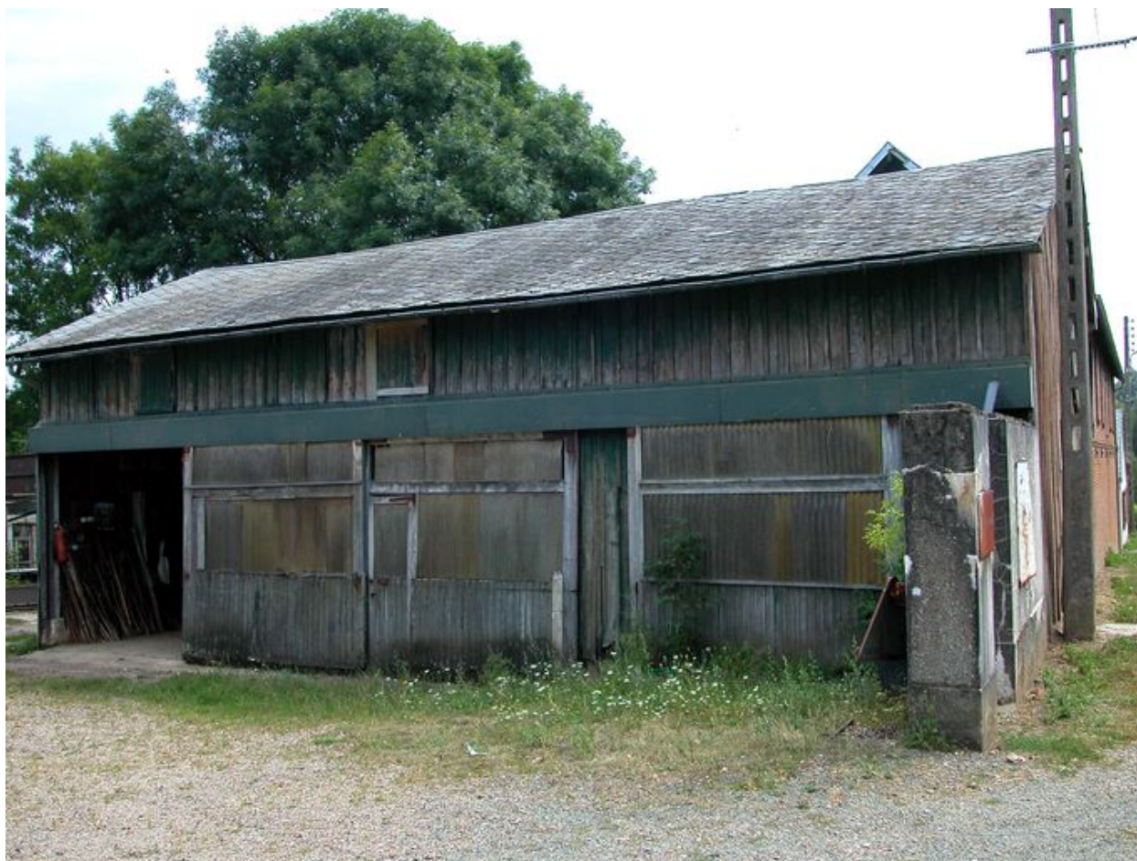
Remise agricole, façade est sur cour.
