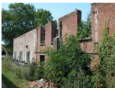
Vestiges d'un hangar, de l'ancien moulin avec sa salle des machines et la chaufferie, façade nord. Phot. Bertrand Fournier IVR22_20036000575NUCA
