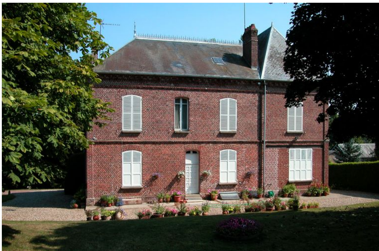
Façade sud de la maison patronale principale.
