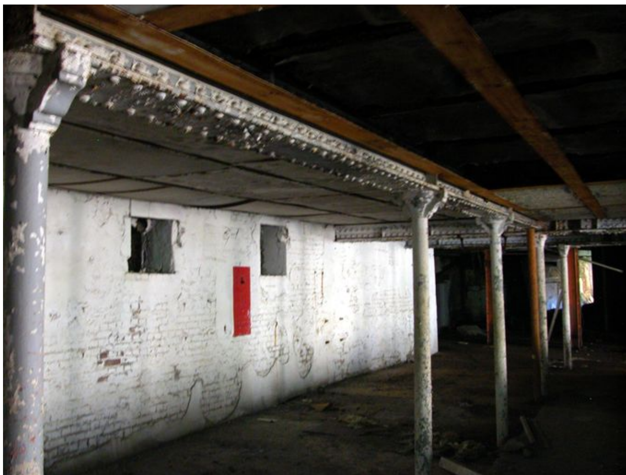
Intérieur du sous-sol de la fromagerie, vue d'ensemble des supports métalliques
