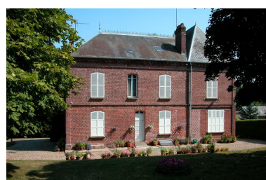
Façade sud de la maison patronale principale.
