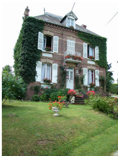
Façade sud de la seconde maison patronale. Phot. Bertrand Fournier IVR22_20036000558NUCA
