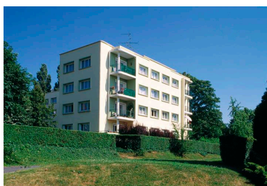
Vue générale de l'immeuble situé à droite du boulevard, élévation sud. Phot. Thierry Petitberghien IVR31_19945901080ZA
