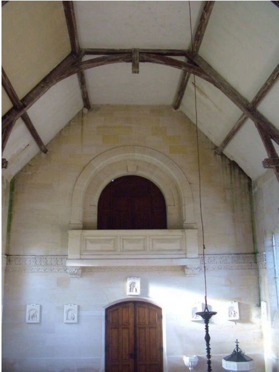
Vue intérieure du mur ouest.
