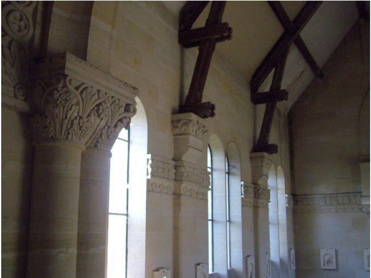
Vue de la rangée de colonnes dans la nef.
