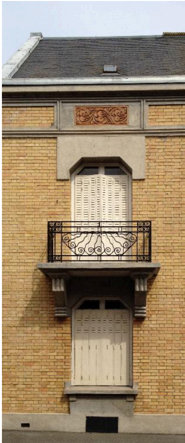
Vue de détail d'une travée de la façade sur rue. Phot. Isabelle Barbedor IVR22_20158006210NUCA
