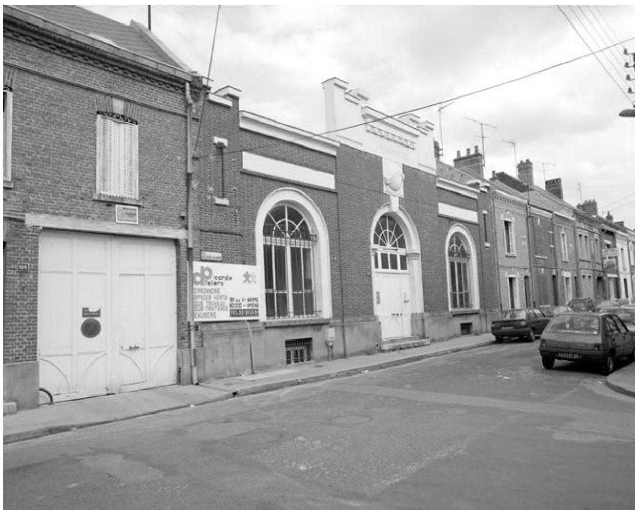
Vue du magasin-réception (élévation antérieure).
