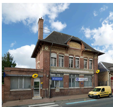
Vue d'ensemble sur rue. Phot. Thierry Lefébure IVR22_20128000608NUC2A
