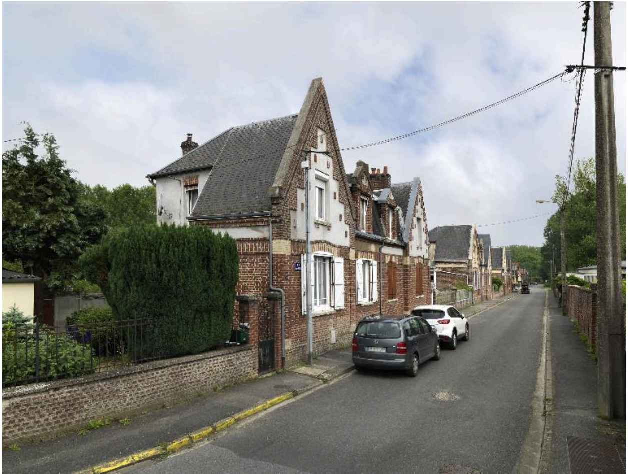
Vue d'ensemble sur rue des trois maisons de contremaîtres.
