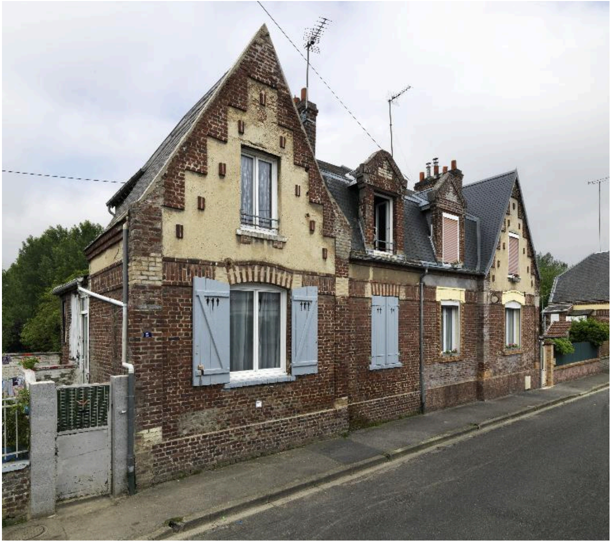
Façade sur rue d'une des maisons de contremaîtres (5-7 rue Pierre-Semard).
