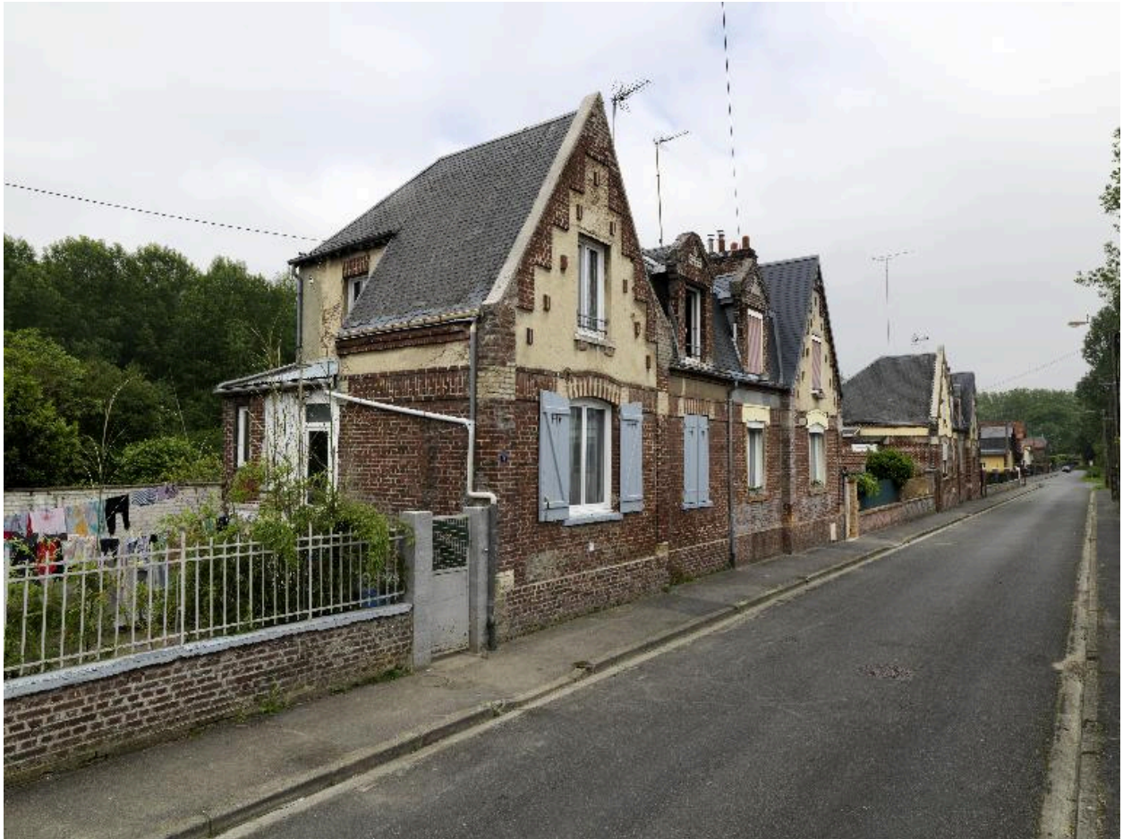
Vue de deux des maisons de contremaîtres (5-11 rue Pierre-Semard), façade sur rue.
