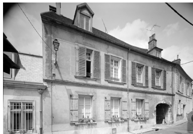
Elévation sur la rue. Phot. Thierry Lefébure IVR22_19930200873P
