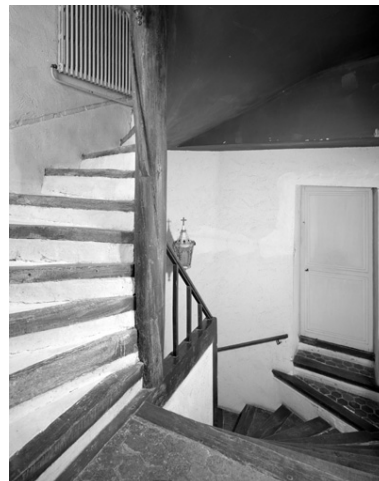
L'escalier, vue prise depuis le premier étage. Phot. Thierry Lefébure IVR22_19930200866V
