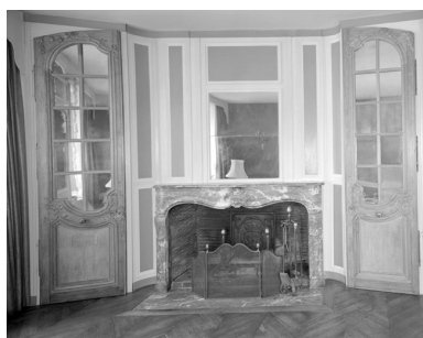
Le salon du rez-de-chaussée, les portes sont rapportées. Phot. Thierry Lefébure IVR22_19930200867V
