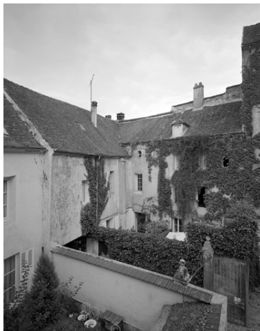
Elévation sur la cour. Phot. Thierry Lefébure IVR22_19930200863V
