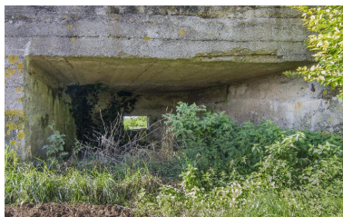
Chambre de tir, vers le nord-ouest Phot. Jean-Marc Ramette IVR31_20145908893NUCA
