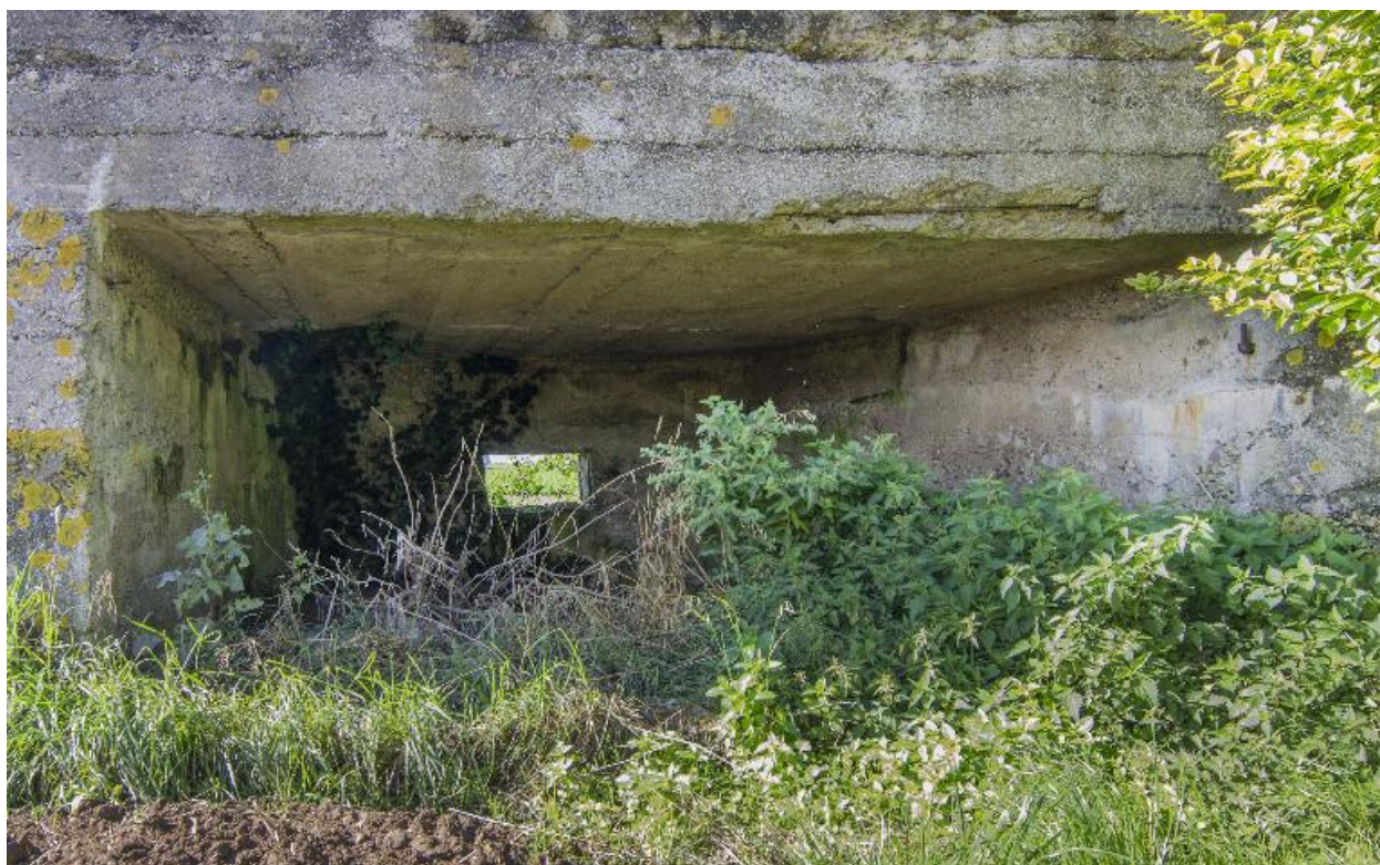
Chambre de tir, vers le nord-ouest
