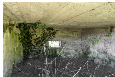
Vue intérieure de la chambre de tir Phot. Jean-Marc Ramette IVR31_20145908894NUCA
