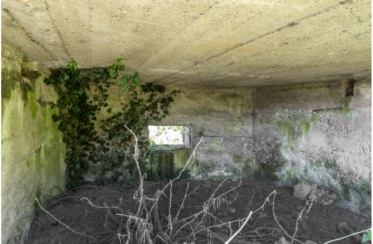
Vue intérieure de la chambre de tir
