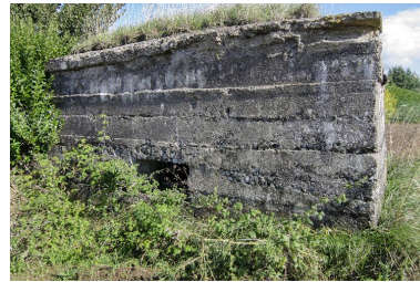
Sortie du canon, élévation nord-ouest Phot. Jean-Marc Ramette IVR31_20145908892NUCA
