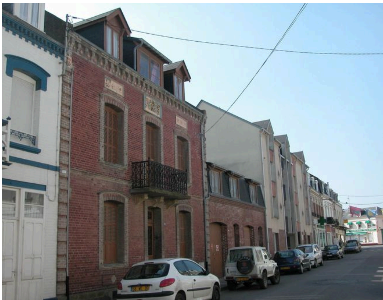
Vue d'ensemble du logis et du garage accolé.
