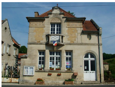
Vue de la mairie. Phot. Inès Guérin IVR22_20030203018NUCA
