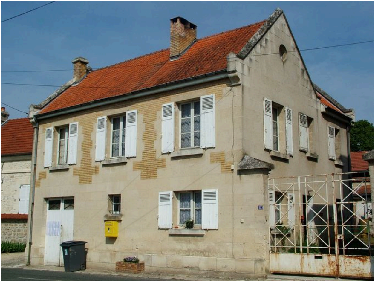
Vue du bâtiment accueillant le logement de l'instituteur.
