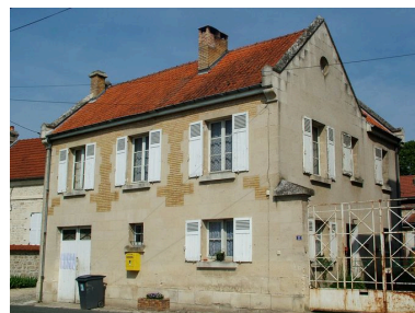
Vue du bâtiment accueillant le logement de l'instituteur. Phot. Inès Guérin IVR22_20030203023NUCA
