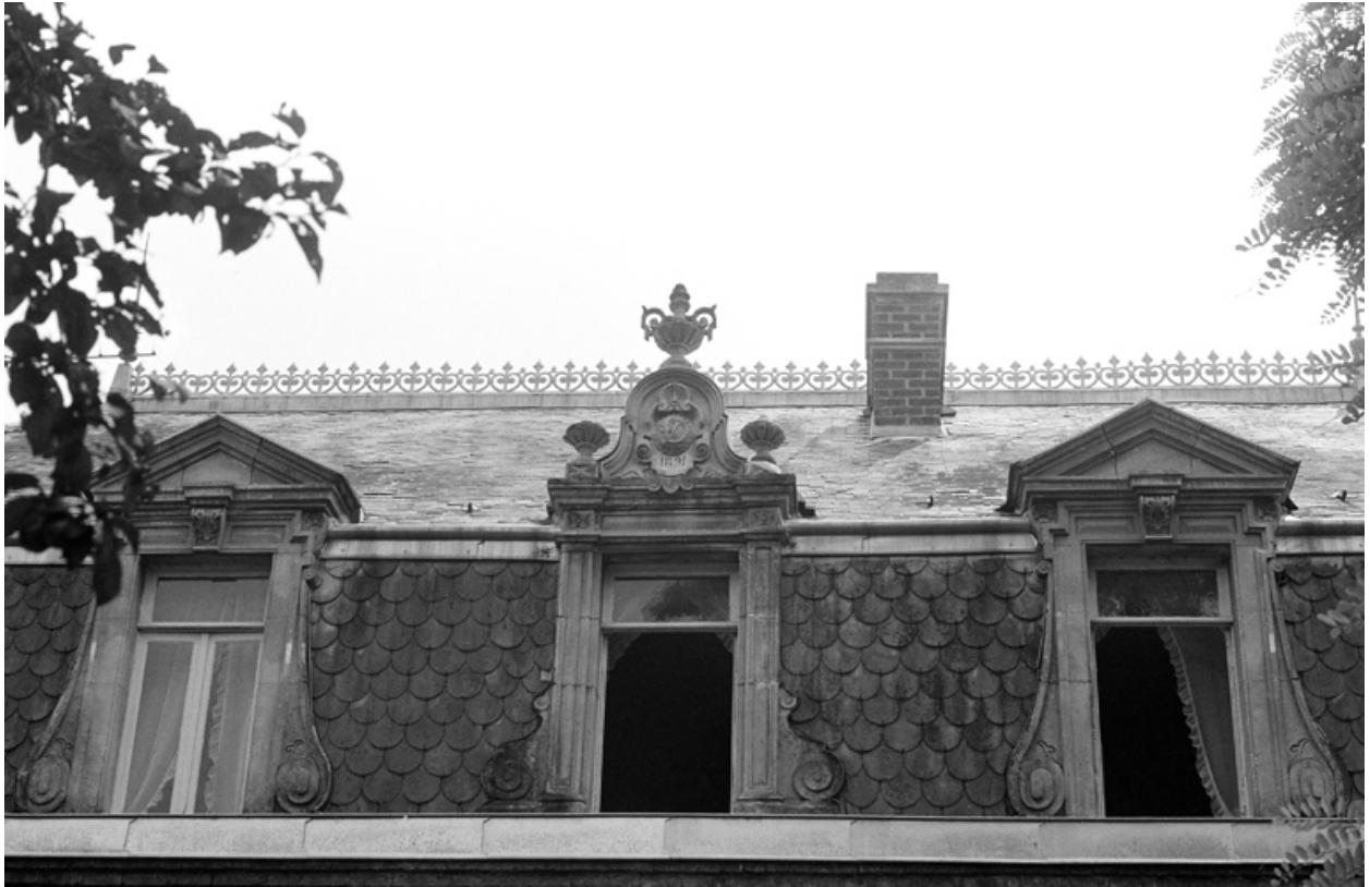
Détail de l'élévation antérieure : le toit brisé.
