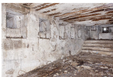
Créneaux de fusillade depuis le niveau intermédiaire vers le premier niveau intermédiaire Phot. Pierre Thibaut IVR32_20165900021NUCA
