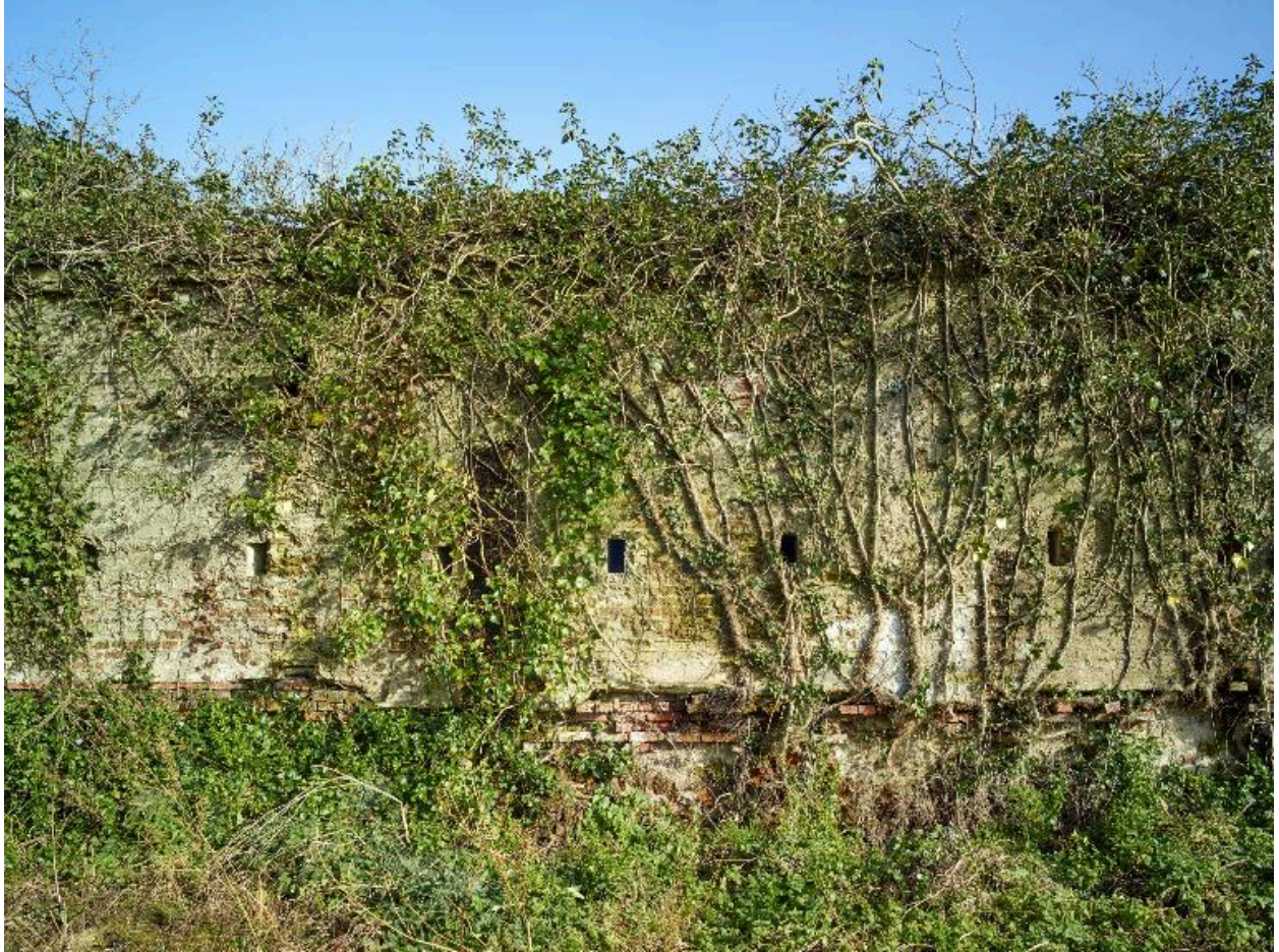
Elévation ouest de la ferme, créneaux de fusillade.
