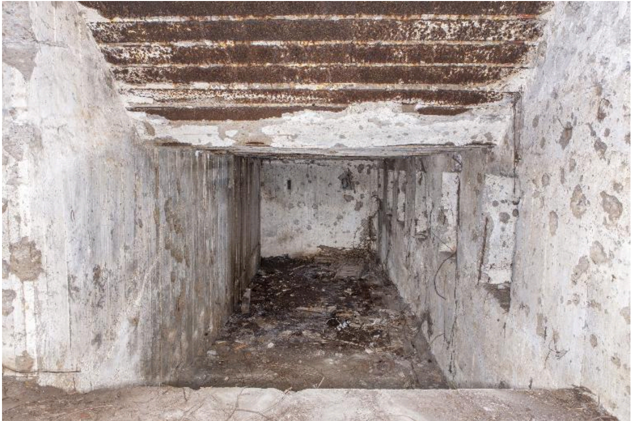
Vue générale, depuis le premier niveau de l'édifice vers le niveau intermédiaire
