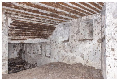
Créneaux de fusillade depuis le premier niveau de l'édifice vers le niveau intermédiaire Phot. Pierre Thibaut IVR32_20165900018NUCA
