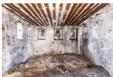
Une des pièces du rez-de-chaussée avec ses créneaux de fusillade Phot. Pierre Thibaut IVR32_20165900022NUCA
