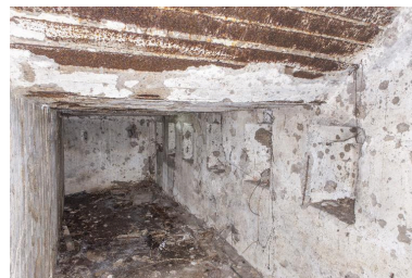
Créneaux de fusillade depuis le premier niveau de l'édifice vers le niveau intermédiaire Phot. Pierre Thibaut IVR32_20165900020NUCA
