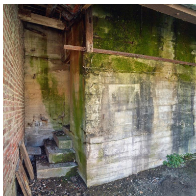
Partie nord de la casemate depuis la cour de la ferme. Entrée conduisant au premier niveau de l'édifice. Phot. Pierre Thibaut IVR32_20185900103NUCA
