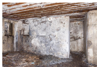
Une des pièces situées au rez-de-chaussée. La porte ouvre sur un petit escalier menant au niveau intermédiaire Phot. Pierre Thibaut IVR32_20165900023NUCA
