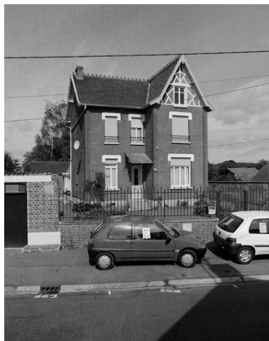
Vue générale depuis la rue de la Résistance. Phot. Philippe Dapvril IVR31_20045900453X
