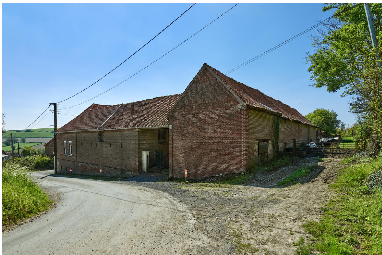
Vue générale depuis le nord.
