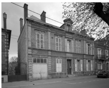
Elévation antérieure. Phot. Fabrice Charrondière IVR22_19866000061V
