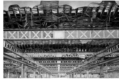
Tissage, détail de la poutraison métallique. Phot. Olivier Marlard IVR31_19885902239X
