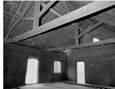
Remise, vue intérieure du premier étage, ferme. Phot. Olivier Marlard IVR31_19885902231X
