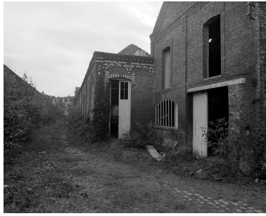
Enfilade entre le mur de clôture et l'atelier de fabrication, vers la rue Victor-Hugo. Phot. Olivier Marlard IVR31_19885902230X
