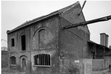
Remise, vue extérieure. Phot. Olivier Marlard IVR31_19885902242X
