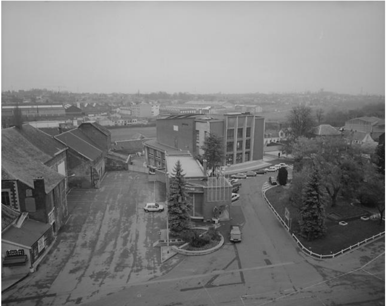
Vue aérienne de l'ensemble centre culturel et hôtel de ville, prise du clocher de l'église.
