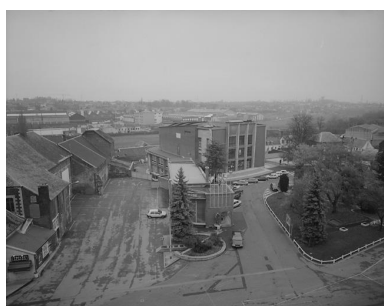
Vue aérienne de l'ensemble centre culturel et hôtel de ville, prise du clocher de l'église. Phot. Olivier Marlard IVR31_19925901617X
