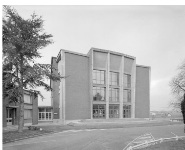
Élévation antérieure de la salle des fêtes. Phot. Olivier Marlard IVR31_19935900201V
