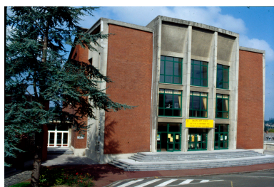
Élévation antérieure de la salle des fêtes. Phot. Olivier Marlard IVR31_19955901118ZA
