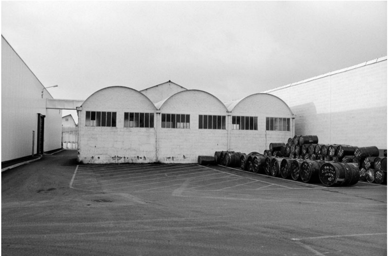
Magasin industriel, flanc est.
