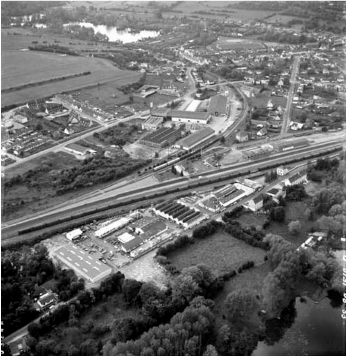
Vue aérienne, flanc nord-est.
