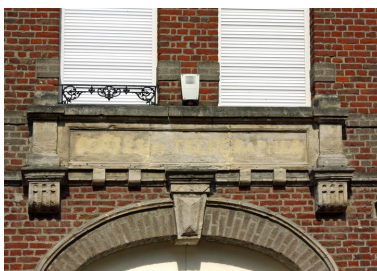
Ancienne poste. Inscription sur la façade : Poste et Télégraphes. Phot. Bertrand Fournier IVR22_20098005825NUCA
