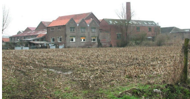
Vue générale arrière de l'usine. Phot. Cyril Cailleau IVR31_20055907376NUCA
