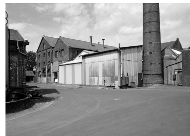
Vue intérieure de la cour, bâtiments industriels et cheminée. Phot. Philippe Dapvril IVR31_20045900393X
