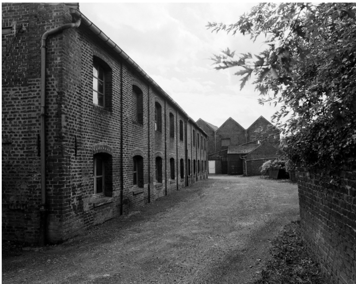
Vue intérieure de la cour, partie originelle des bâtiments industriels.
