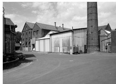
Vue intérieure de la cour, bâtiments industriels et cheminée. Phot. Philippe Dapvril IVR31_20045900393X
