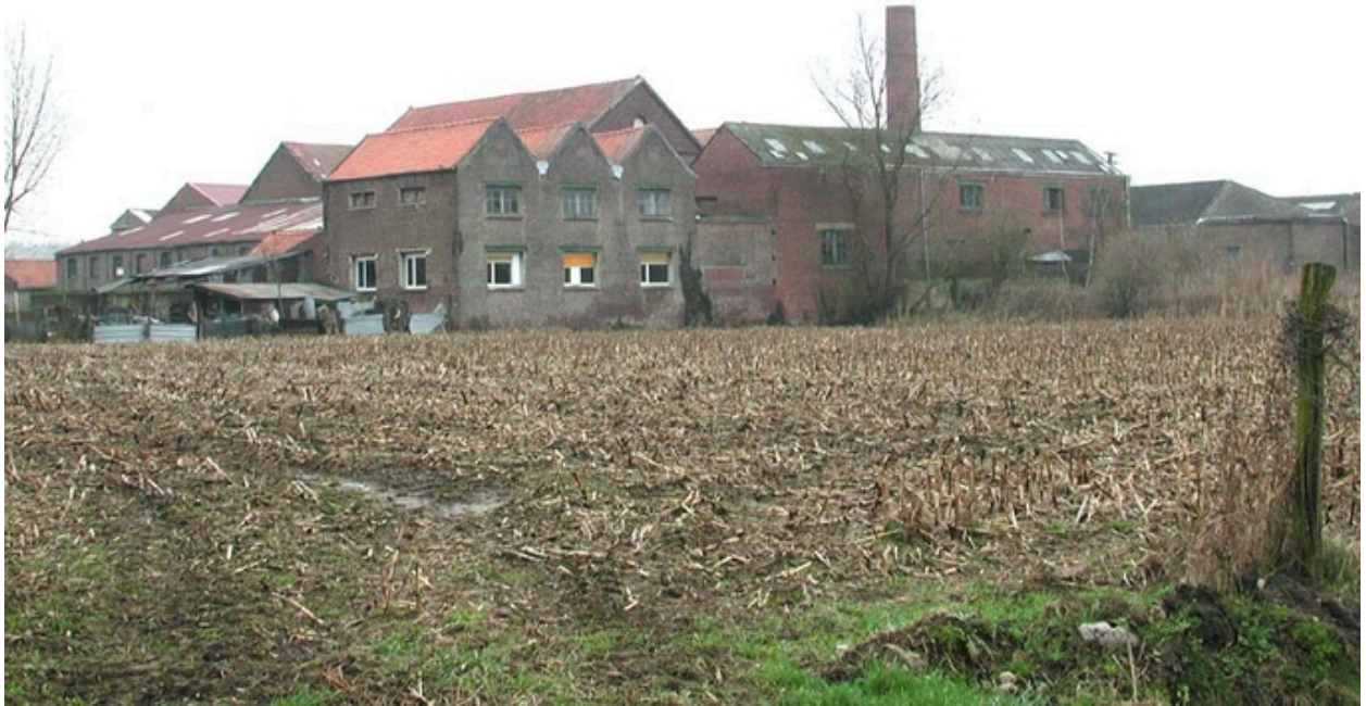
Vue générale arrière de l'usine.
