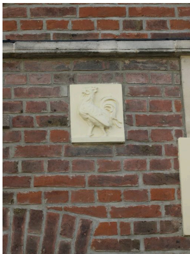
Détail sur la plaque : le Coq. Phot. Isabelle Barbedor IVR22_20048010476NUCA
