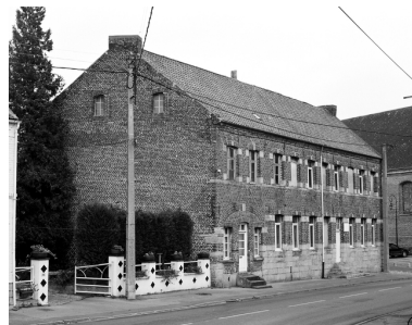
Vue générale. Phot. Philippe Dapvril IVR31_20045900657X
