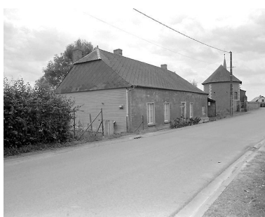
Vue générale. Phot. Laurent Jumel IVR22_19980202894X
