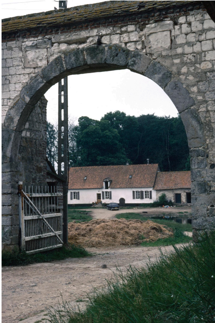
Vue générale du logis du fermier sur cour.
