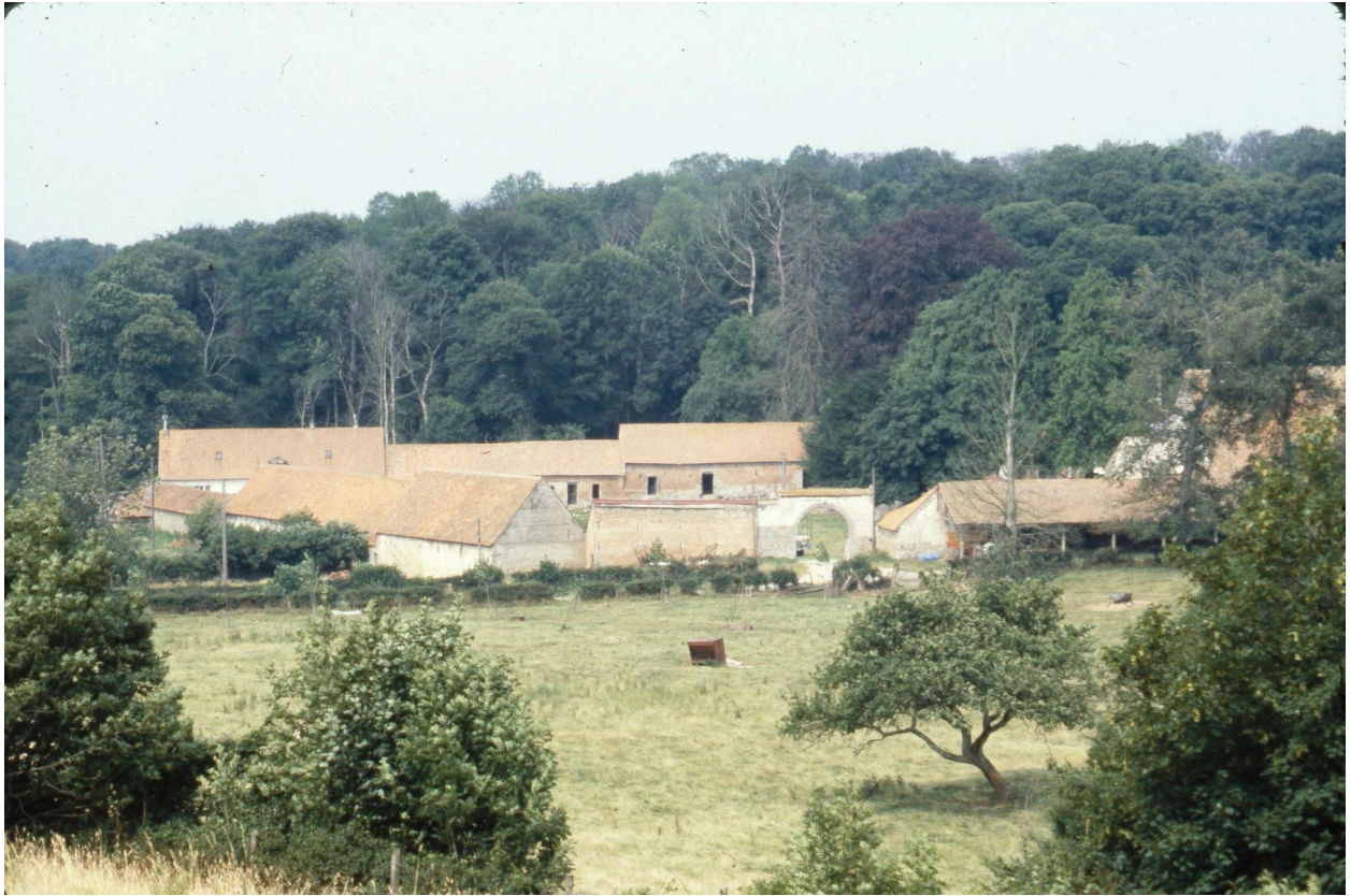
Vue générale de la ferme du Fayel prise depuis l'est.
